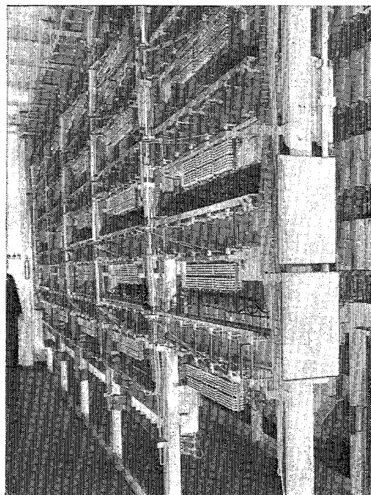
Aspecto do Automático Norte
