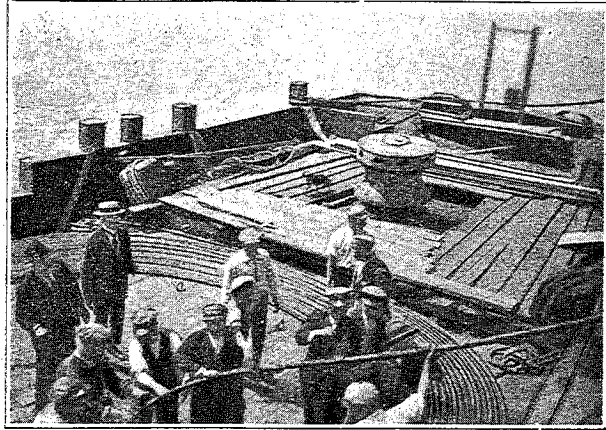
Montagem do Cabo Submarino
