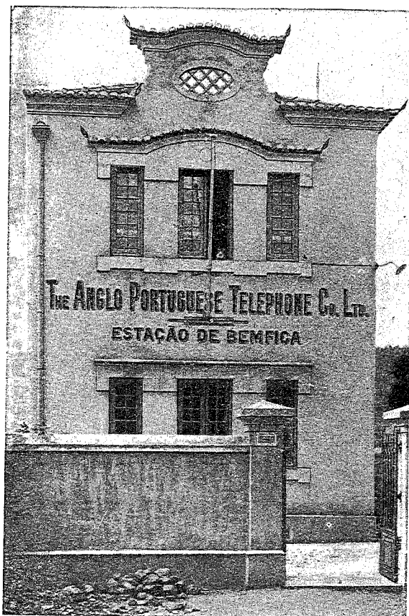
A Estação de Bemfica, edifício em estilo português, construído pela A. P. T.
